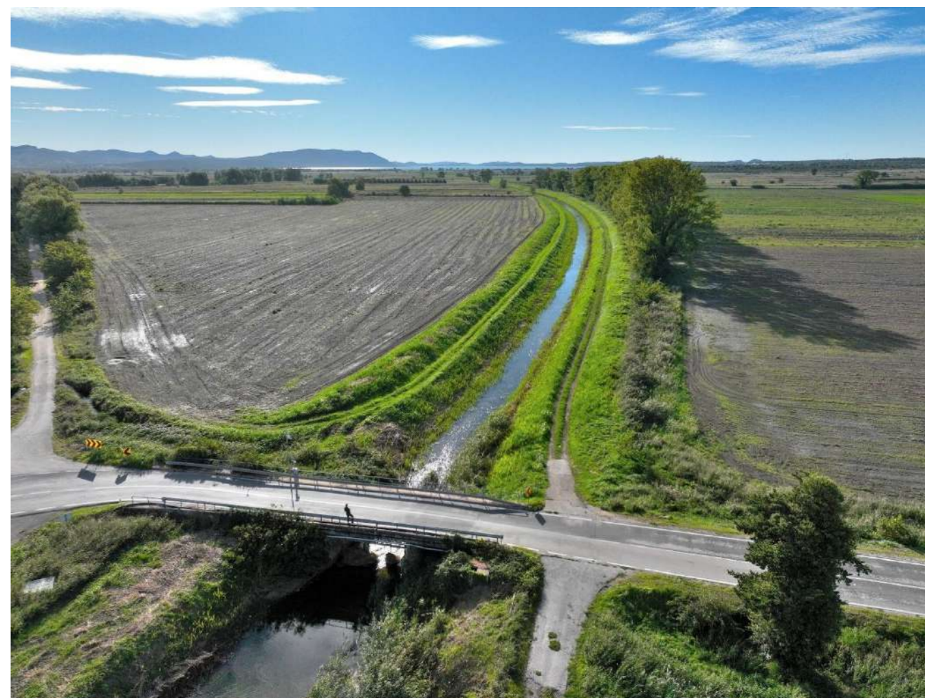
Sl. 86. Glavni kanal (Kotarka)
