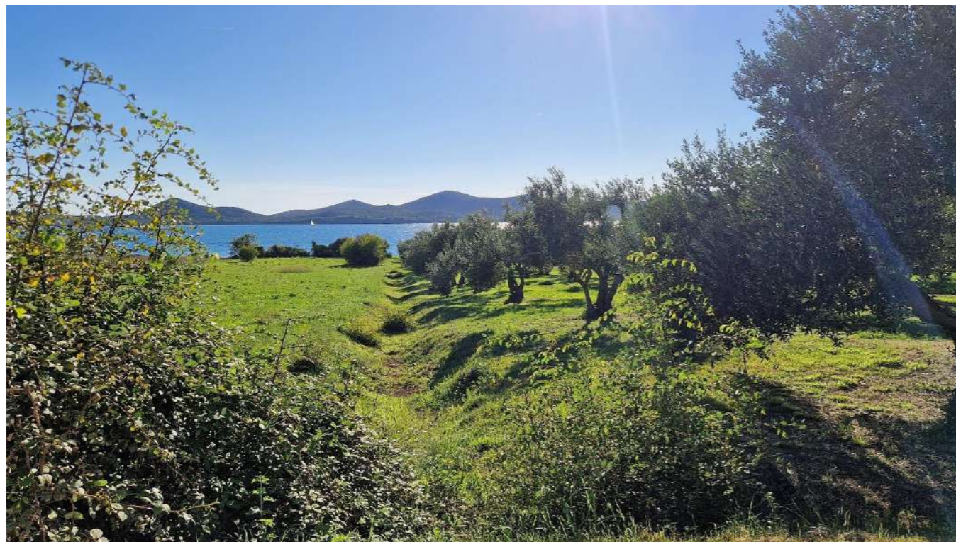
Sl. 91. Odvodni kanal za oborinsku vodu uz maslinik u obalnoj zoni
